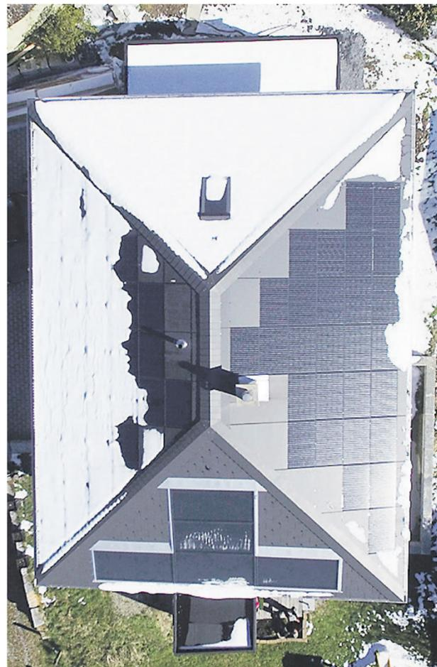
Nordseite mit Schnee bedeckt, Ost- und Westseite des Dachs mit PV (Strom)-Modulen und Südseite mit thermischen (Warmwasser)-Kollektoren. Foto: S. Grätzer
